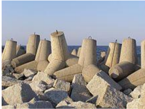
Figura 9. Tetrapodi utilizzati come frangiflutti
